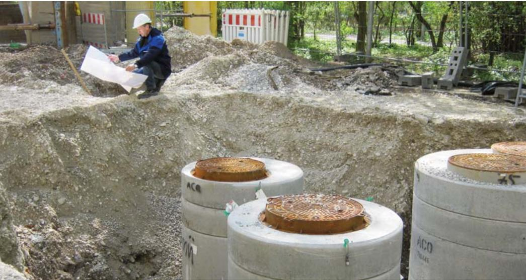
Prüfung einer Anwesensentwässerung durch einen Kontrollmeister der Münchner Stadtentwässerung. Durch die regelmäßigen Kontrollen wird eine fachgerechte Ausführung der Planung sichergestellt.
